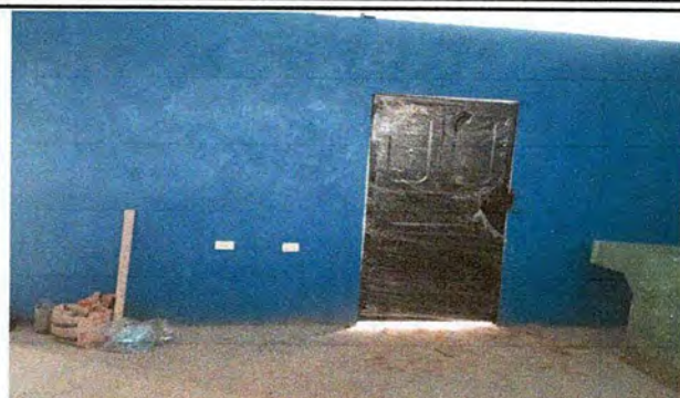
Foto 2: Colocación de puertas y pila.
