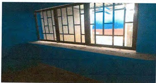
Foto 3: Colocación de ventana.
