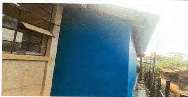
Foto 5: Parte trasera de la cocina finalizada.
